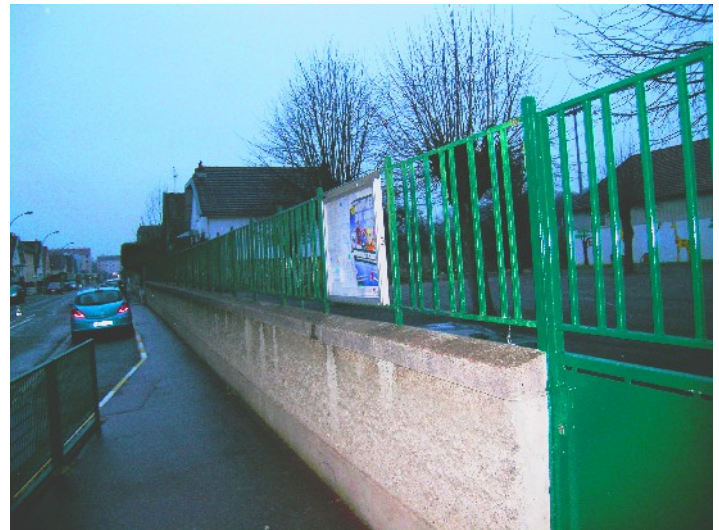
Vue du trottoir
